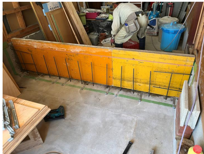
基礎立上り新設
