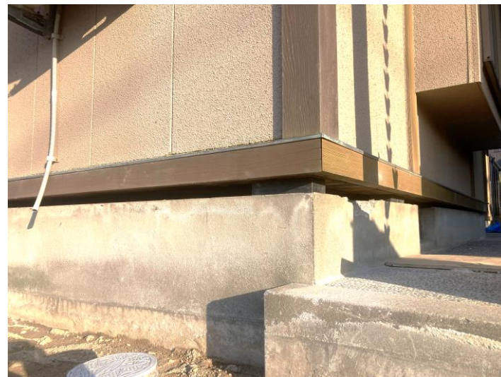
沈下修正状況（パッキン取付）
