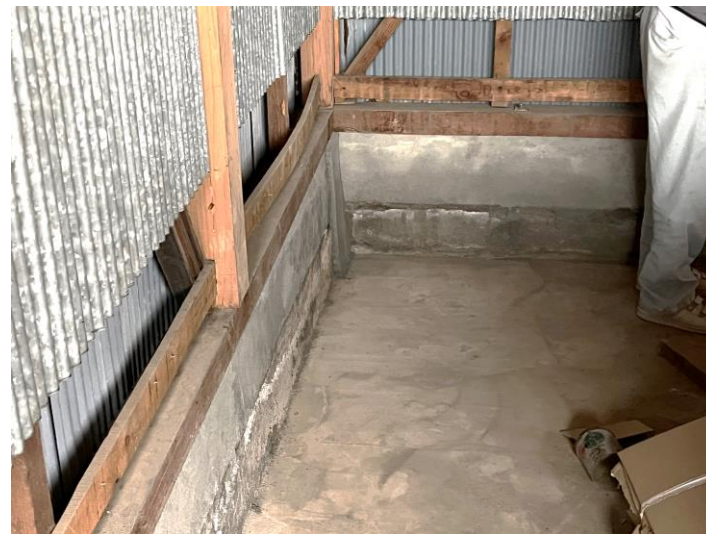
立上り コンクリート増打ち
