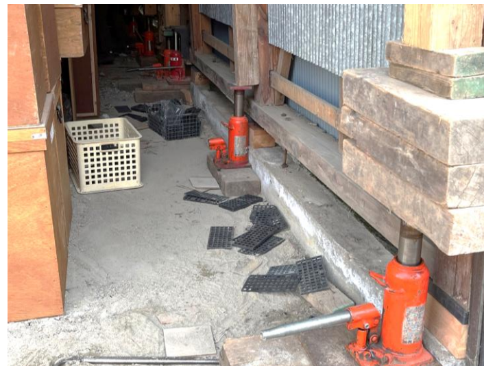
ジャッキアップ状況
