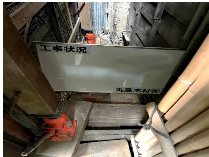
ジャッキアップ状況
