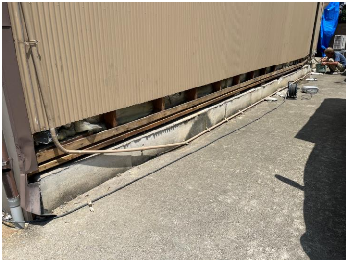
外部沈下修正状況
