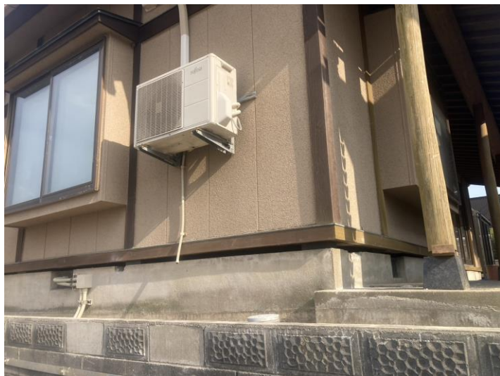
沈下修正状況
