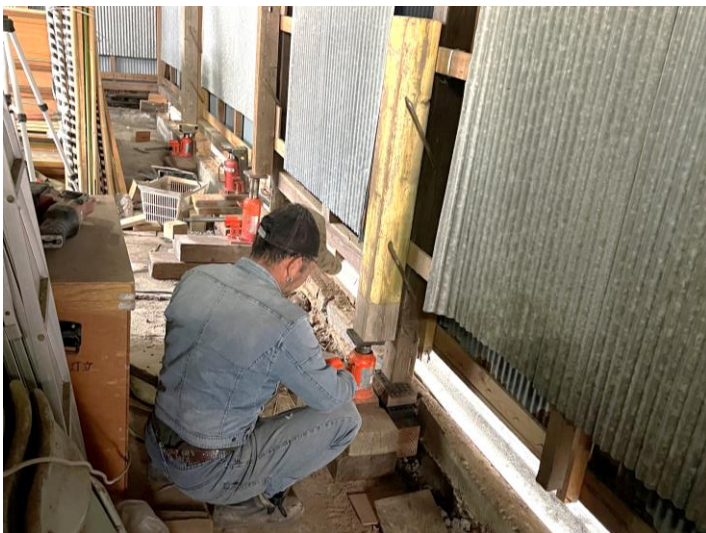
ジャッキアップ状況
