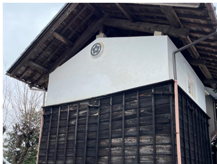
土蔵壁 補修完了
