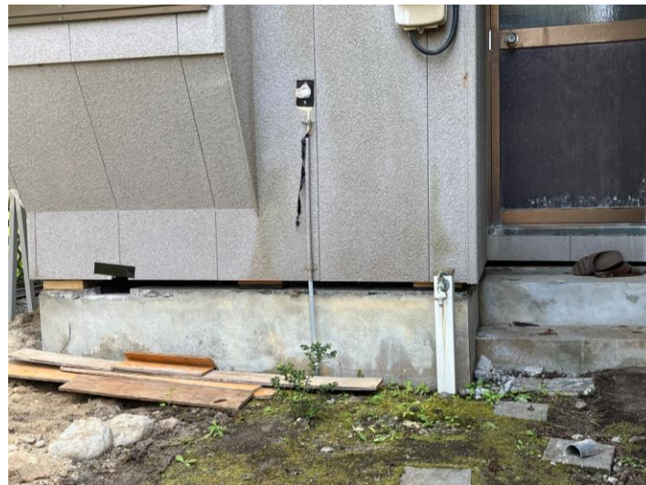
沈下修正状況（外廻り）
