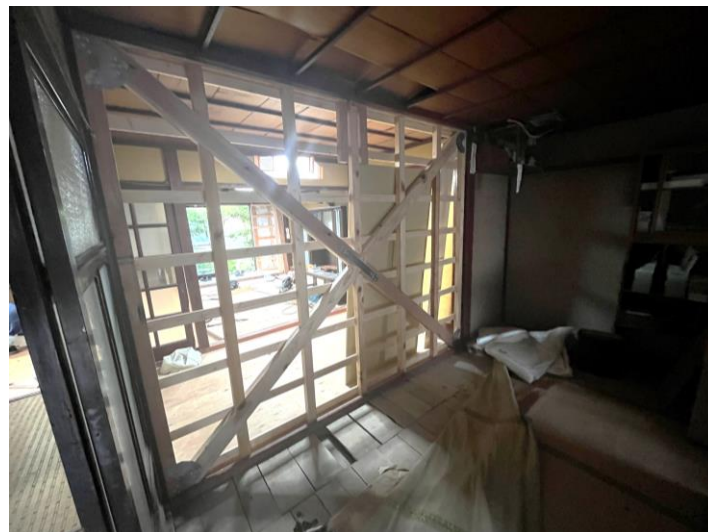
補強状況（和室内部） （基礎新設＋スジカイ＋構造用合板）
