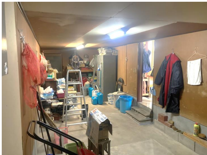
補強前（車庫内部）
