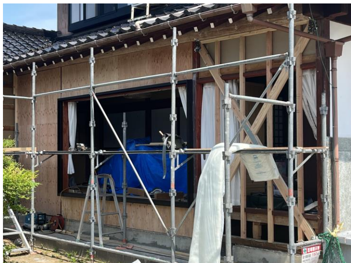
補強状況（スジカイ + 構造用合板）
