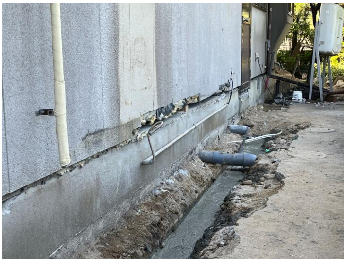
外部基礎廻り地盤コンクリート補充
