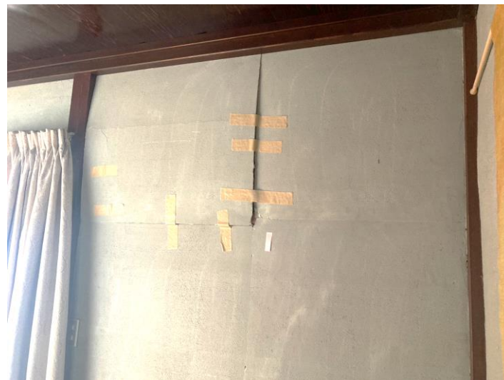
壁破損状況
