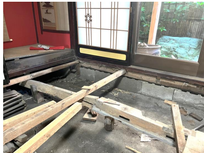
沈下部分 床解体
