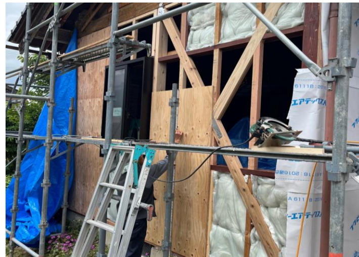
補強状況（スジカイ + 構造用合板）
