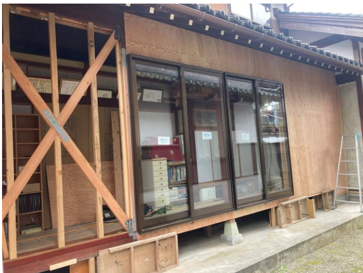
補強状況（スジカイ + 構造用合板）
