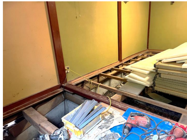
沈下修正状況（和室内） 横打ち金具
