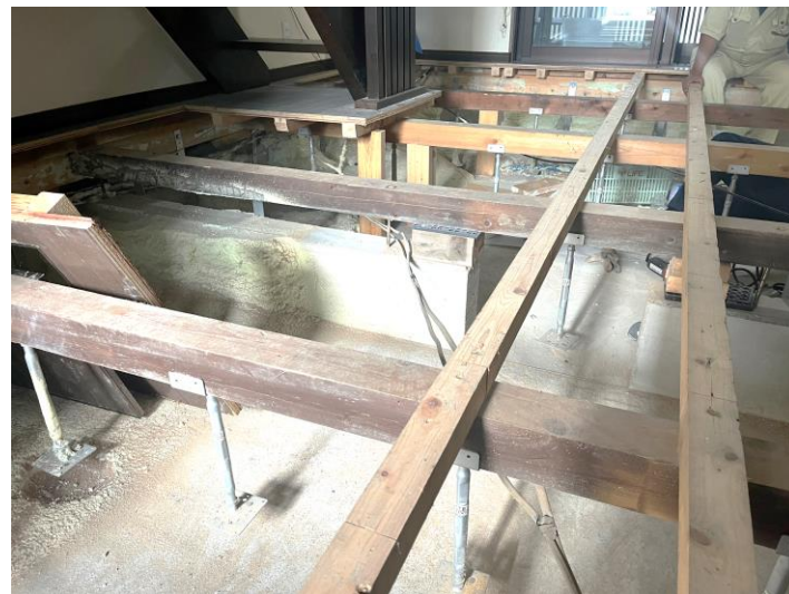
沈下修正状況（洋室内）
