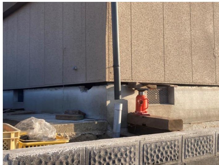
ジャッキアップ状況
