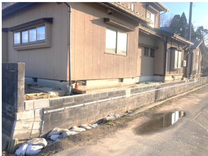
ジャッキアップ状況
