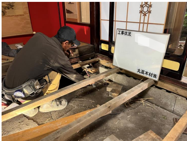
沈下修正状況（パッキン）
