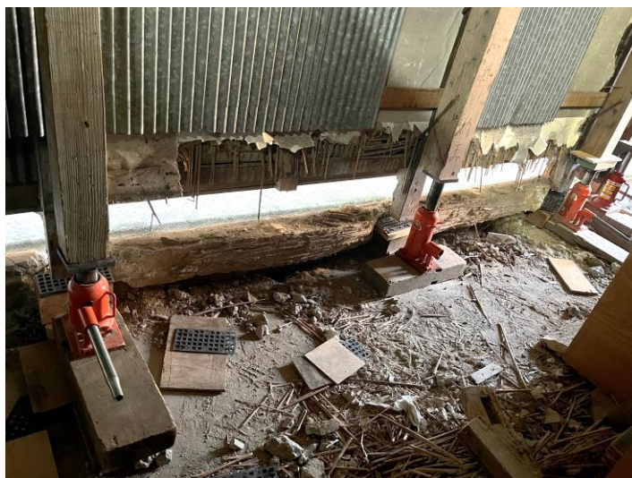
ジャッキアップ状況
