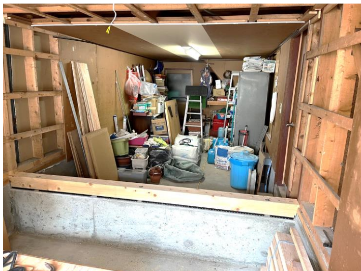
基礎新設 + 土台取付
