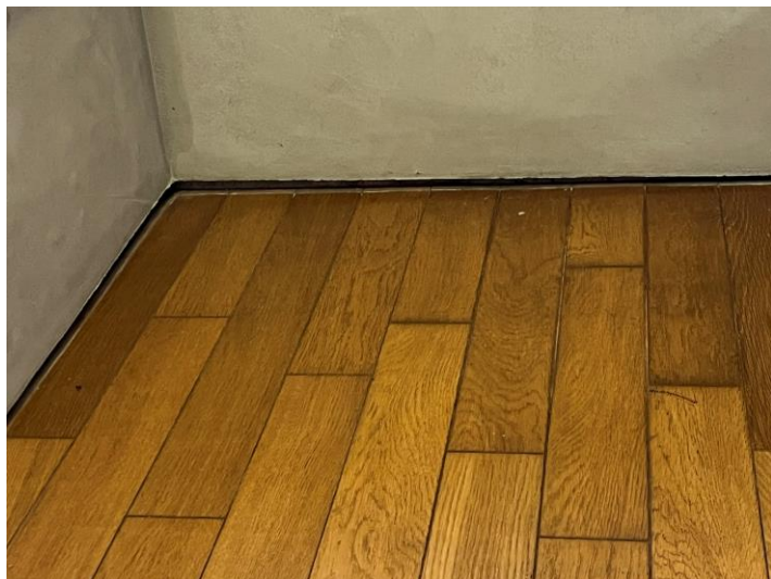
内部床沈下
