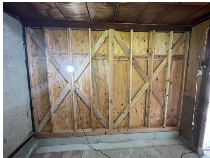
補強状況（正面） （基礎新設＋スジカイ＋構造用合板）
