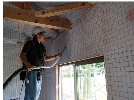
断熱工事(セルロースファイバー)
