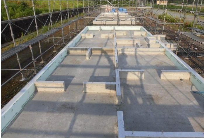
基礎工事(間仕切り部分は立ち上がり)
