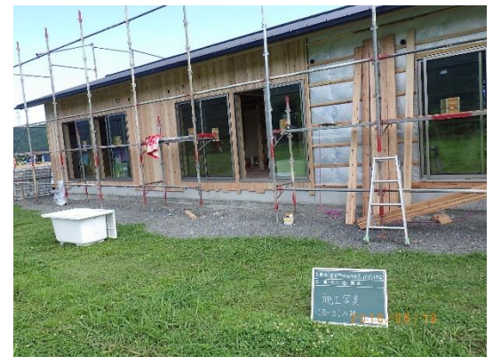
外壁工事(熊本県産杉板張り)
