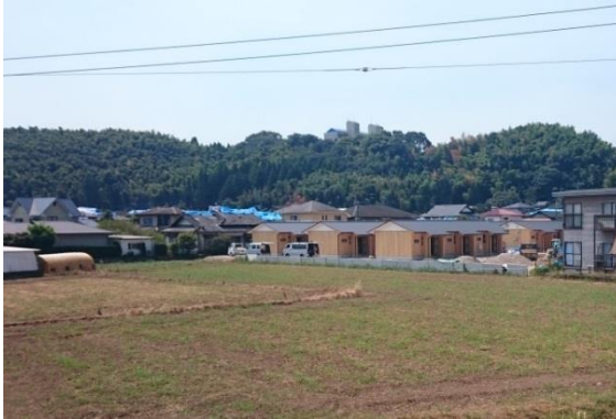
住宅地でも違和感ない木造仮設
