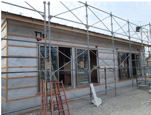
透湿遮熱シート工事
