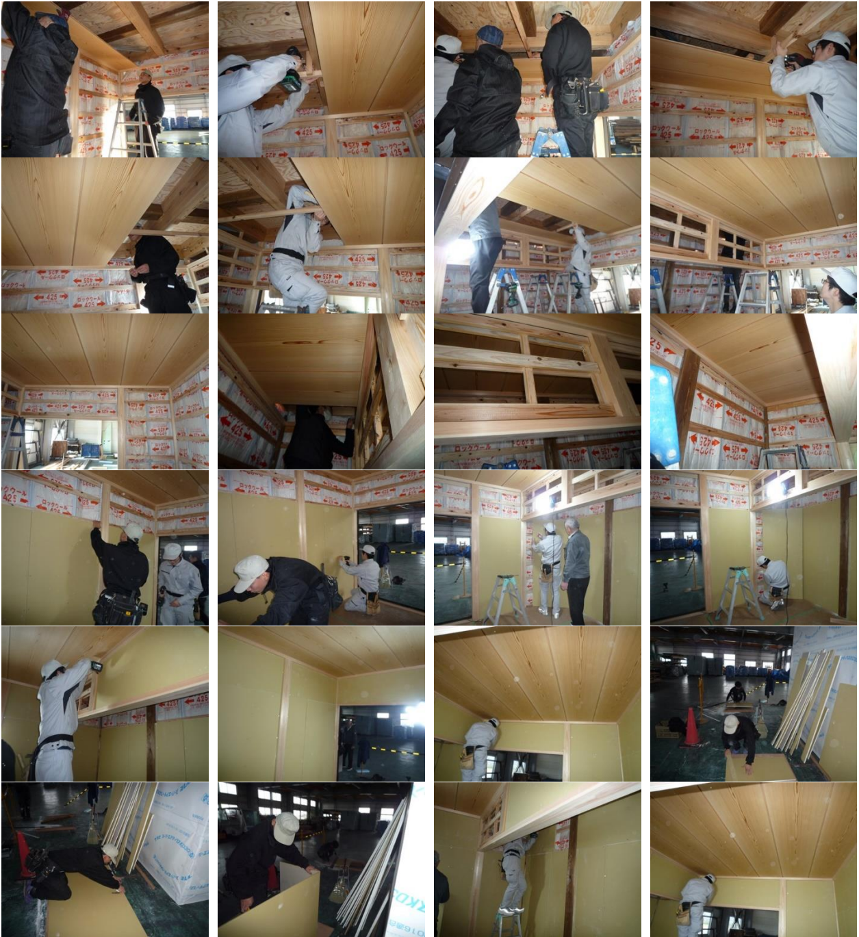
12/25 天井板張り、壁 plasterボード張り、付鴨居寄せ・取付、押入中段取付（完成）
