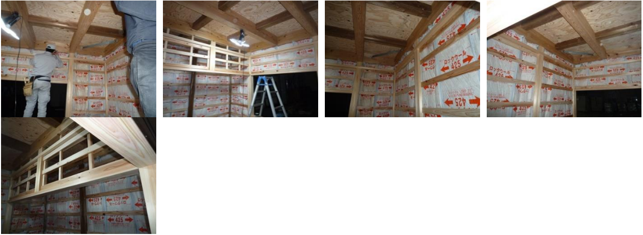
12/25 天井板張り、壁 plasterボード張り、付鴨居寄せ・取付、押入中段取付（完成）
