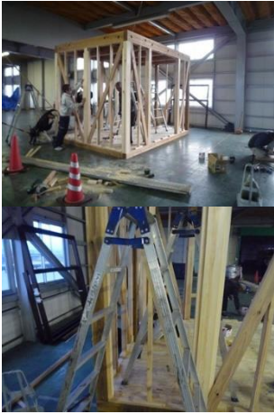
12/4 敷居鴨居刻み・取付、間柱・吊り塚取付
