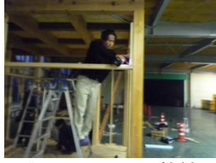
12/11 サッシ取付、タイベック張り、断熱材、内部貫下地、フロア張り
