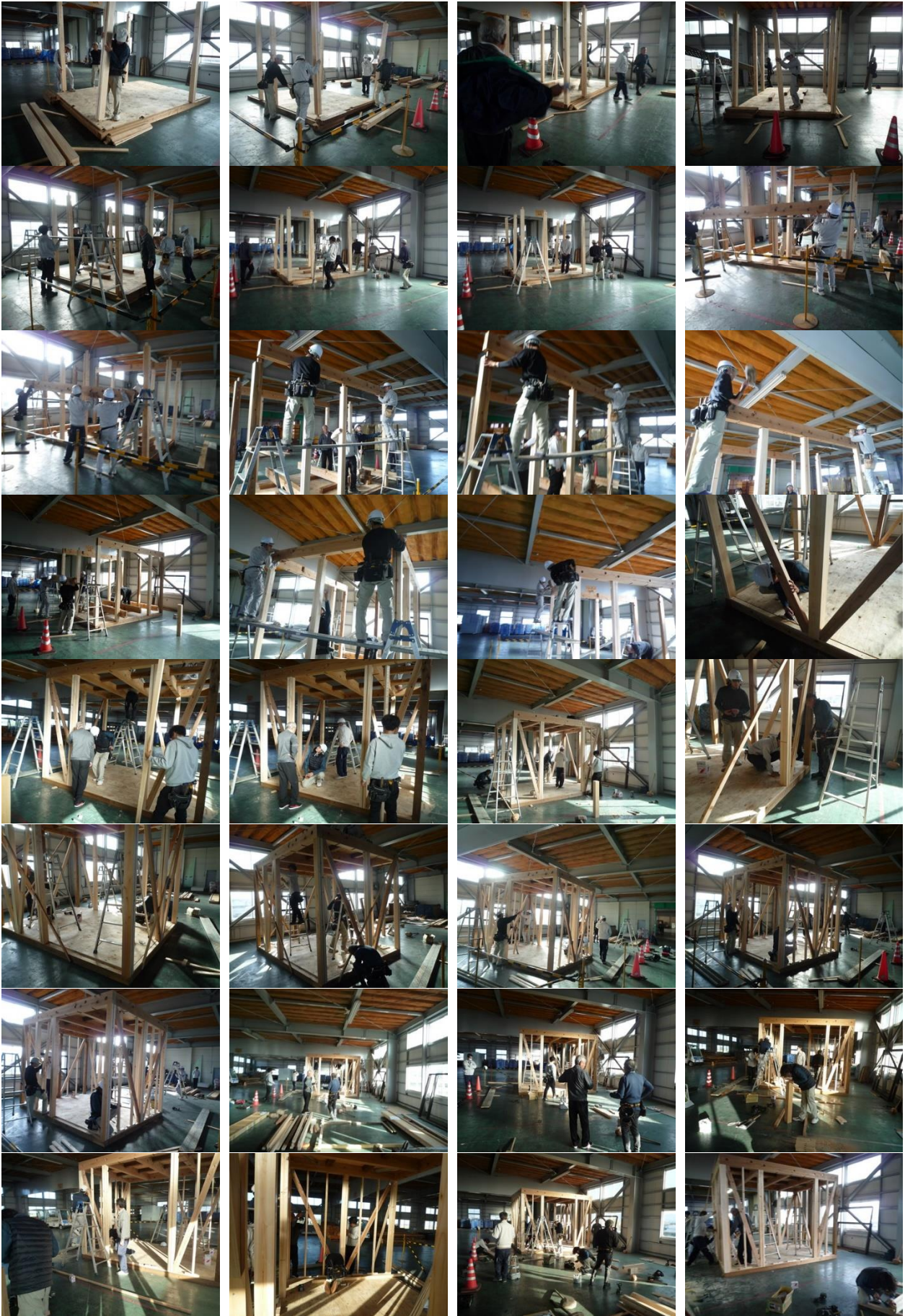
11/27 建方 間柱・筋交い取付
