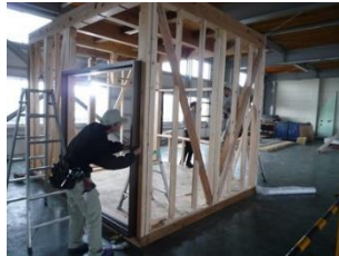
12/11 サッシ取付、タイベック張り、断熱材、内部貫下地、フロア張り
