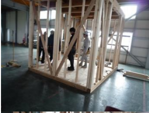
12/4 敷居鴨居刻み・取付、間柱・吊り塚取付
