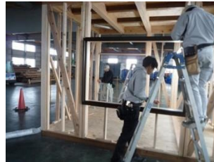
12/11 サッシ取付、タイベック張り、断熱材、内部貫下地、フロア張り
