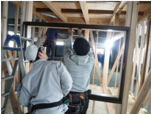
12/11 サッシ取付、タイベック張り、断熱材、内部貫下地、フロア張り
