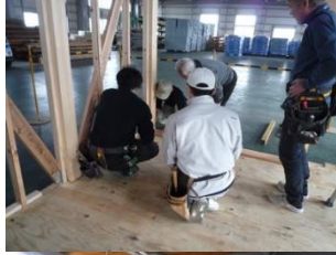
12/4 敷居鴨居刻み・取付、間柱・吊り塚取付
