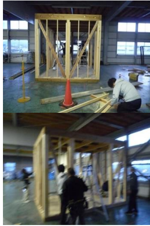
12/4 敷居鴨居刻み・取付、間柱・吊り塚取付
